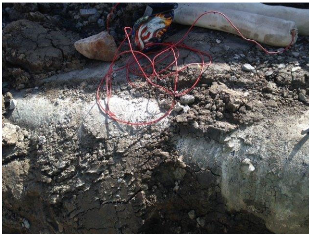
Figur 5:4 Offeranoder ansluts till skruven.
