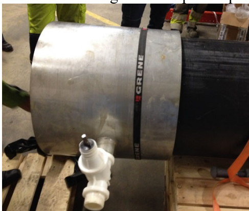
Figur 7:1 Ångjanne på befintligt PE-rör.
