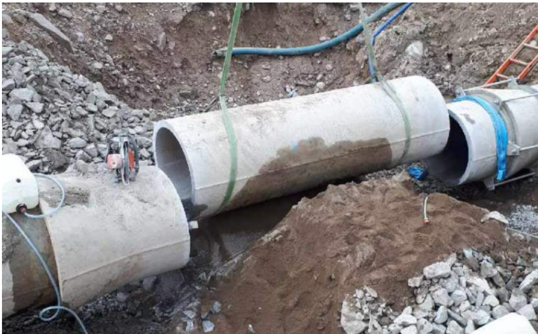
Figur 1:1 Det går ofta mycket tungt att dra ut rörbitarna, framför allt vid större dimensioner. Tänk på att skydda de fria rörändarna där sammanfogningen ska ske så att rörbiten som avlägsnas inte svänger loss och skadar dessa. Då måste även nästa rör bytas!
