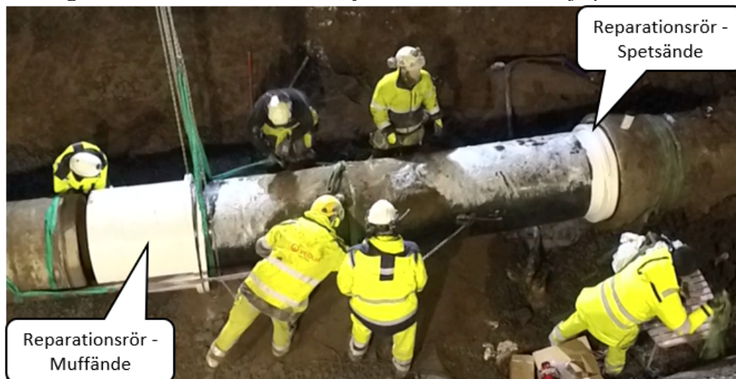
Figur 1:4 För att få riktningen korrekt kan det vara bra att ha ett dragblock på lyftstropparna för manuell riktning vid höjning och skänkning av röret.
