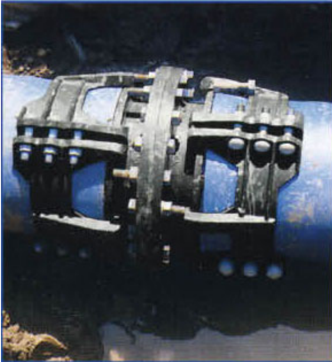
Figur 7:5 Det båda PE-rören monteras ihop med flänsförbandet.
