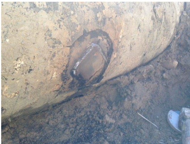
Figur 5:2 Fastsvetsat plattjärn.
