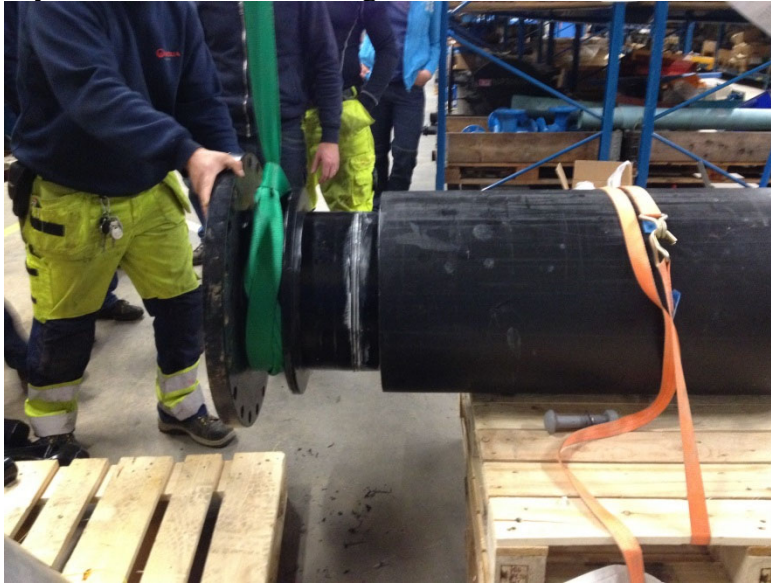
Figur 7:3 Flänsände förs in i PE-rör.
