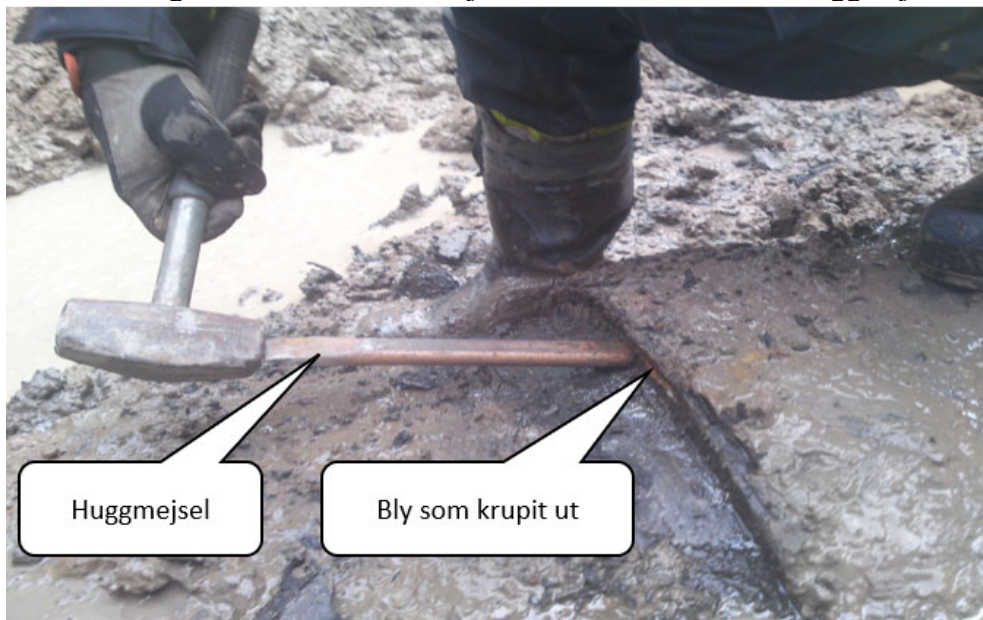
Figur 5:5 Diktning av blyskarv
