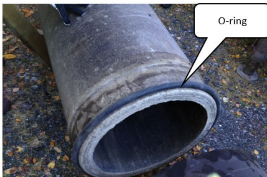
Figur 1:5 O-ring monteras på befintligt Sentabrör.
