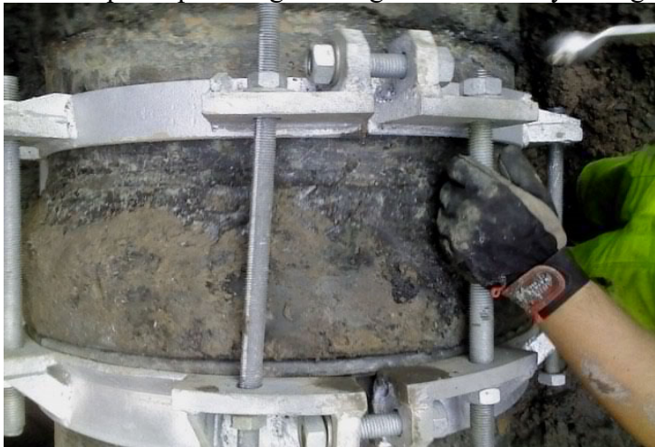
Figur 5:8 Gängstänger monteras.
