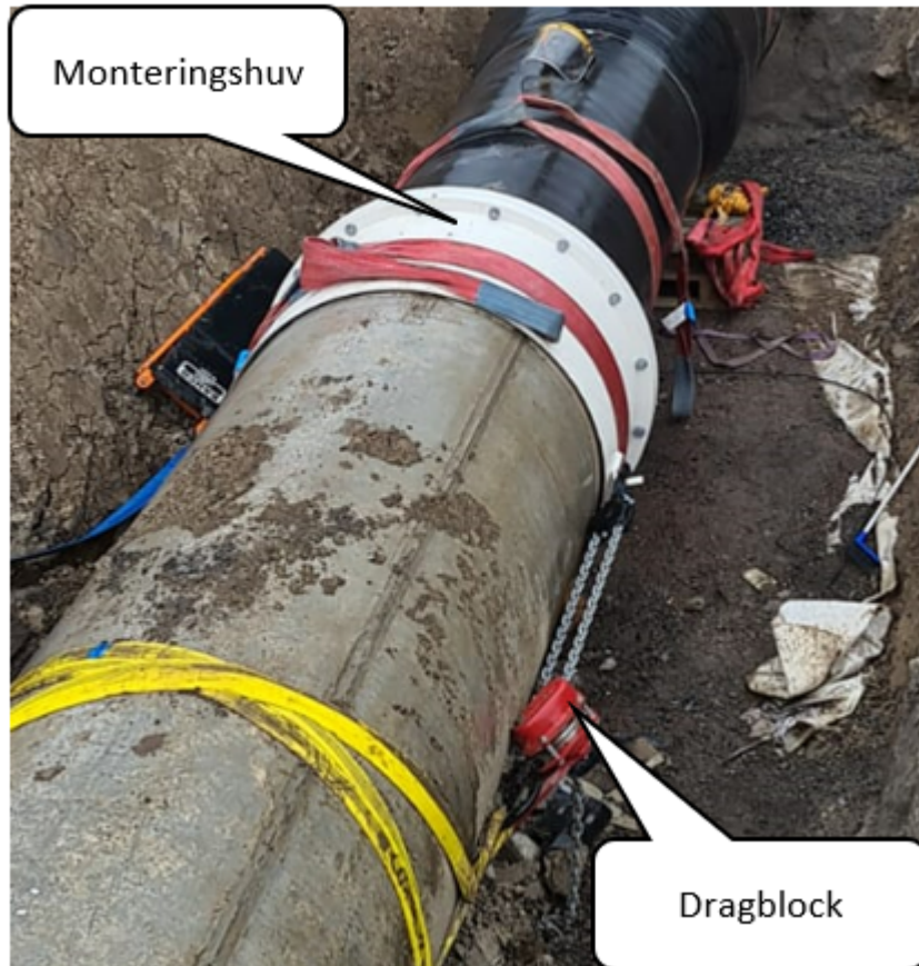
Figur 1:6 Monteringshuv spelas på plats med dragblock.
