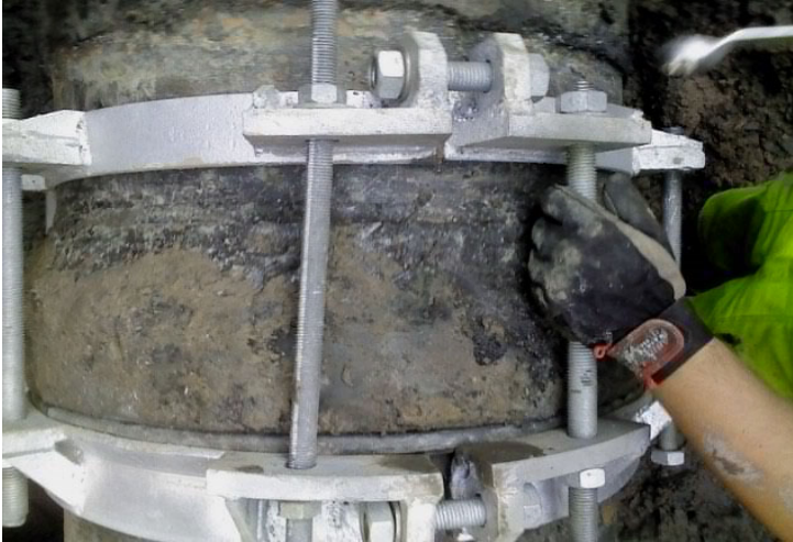
Figur 1:11 Gängade stänger monteras
