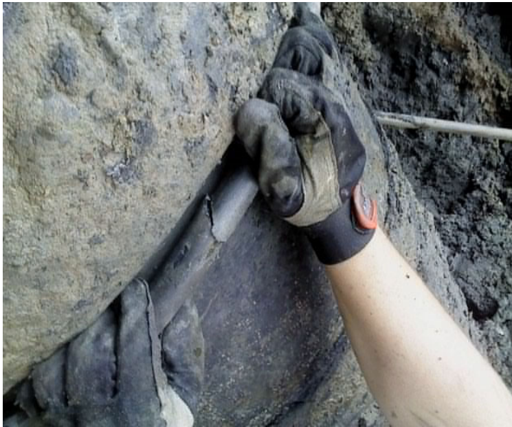
Figur 1:9 Snedskuren O-ring monteras vid skarv.
