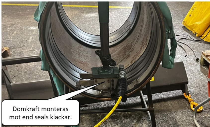
Figur 8:3 Domkraft med stag monterad.
