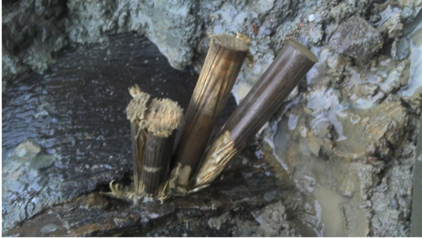
Figur 5:1 Träpluggar slås in i hålet.
