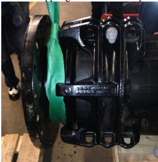
Figur 7:4 Kopplingens yttre del monteras utanpå PE-röret.
